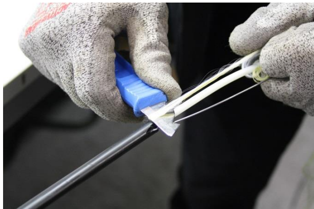
Katkaistaan vaipan juuresta vaipan alla olevat vahvikkeet.
