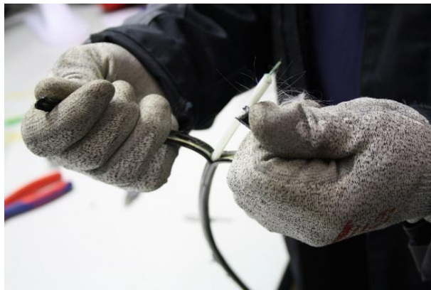
Otetaan kiinni vaipan puoliskoista ja vedetään ne erilleen ja katkaistaan kuorinnan aloituskohdassa.
