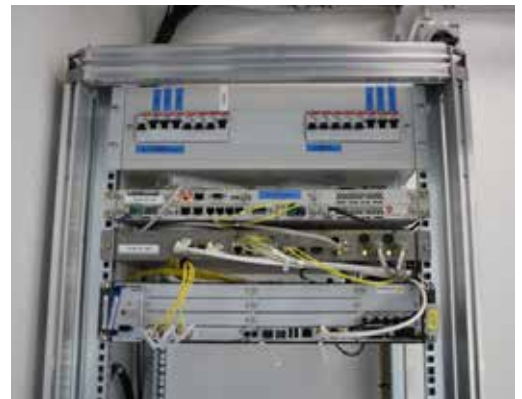
Oikealla ylhäällä ja alhaalla: Nousukaapelin alapään häntäkaapelit on kytketty suoraan aktiivilaitteisiin.
